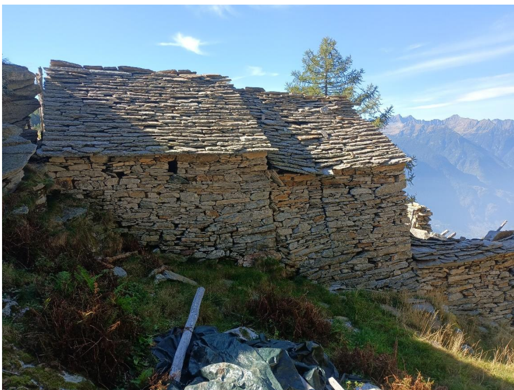
Vista lato nordest
