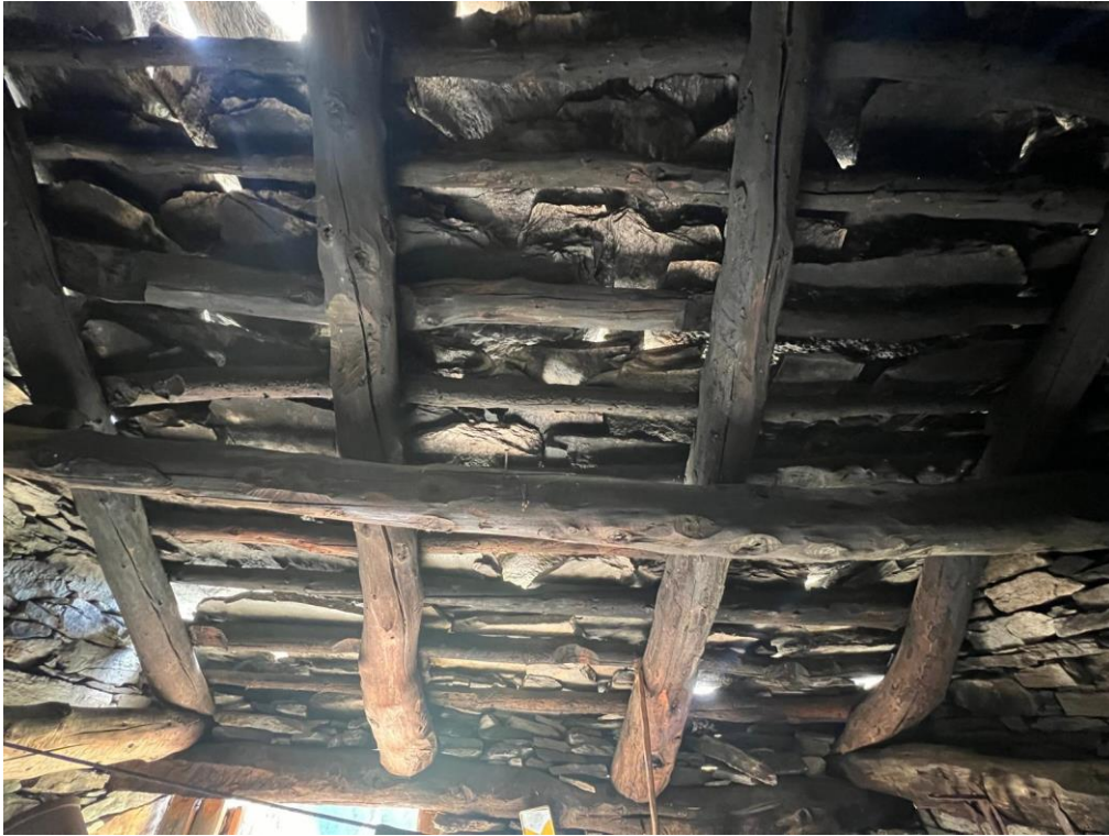
Dettaglio carpenteria da sostituire
