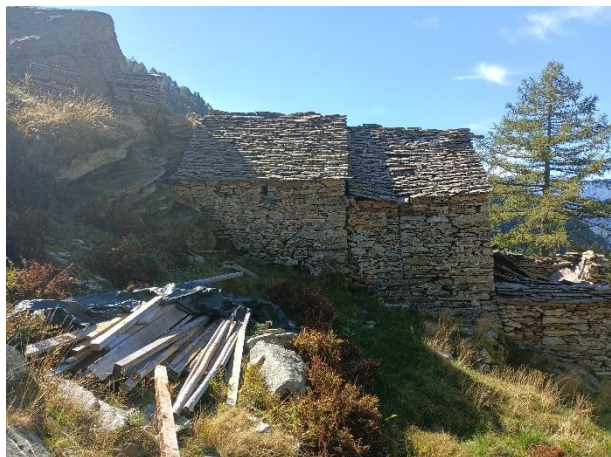
Img. 4: Muro e tetto visto dall'altro lato
